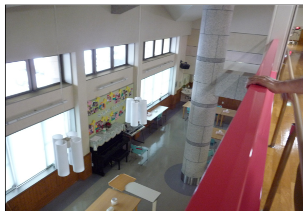
写真 15. 2階吹き抜け部分の廊下の手すり 1階との吹き抜け部分での転落の可能性があるため、手すりを赤色にして目立たせ、分かりやすくしている。
