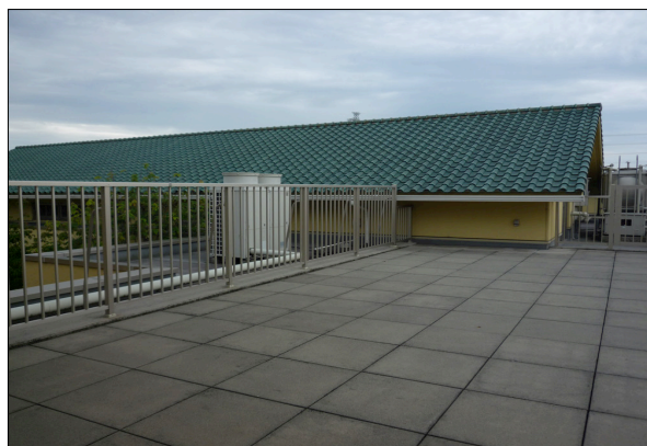
写真 16. 屋上空間 屋上には避難経路を確保し、ビアガーデンでも使用している。
